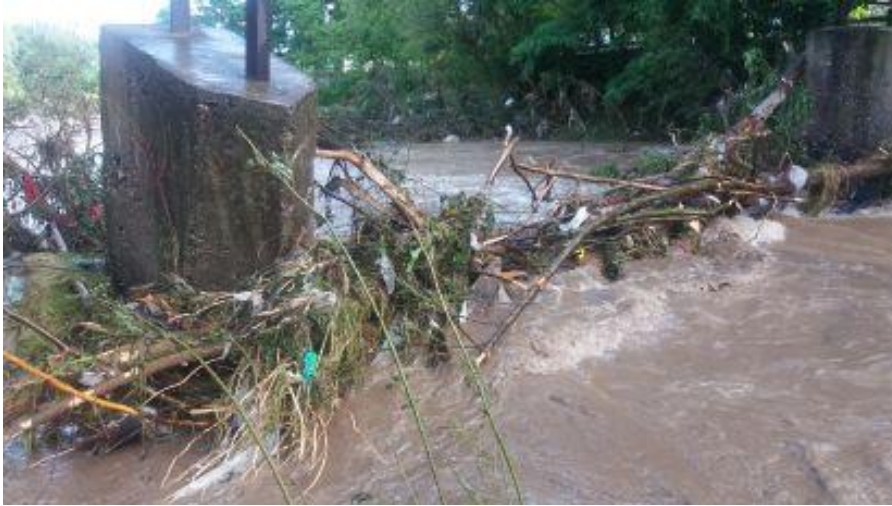
Obturarea sectiunii de scurgere a raului Valea Geoagiului
