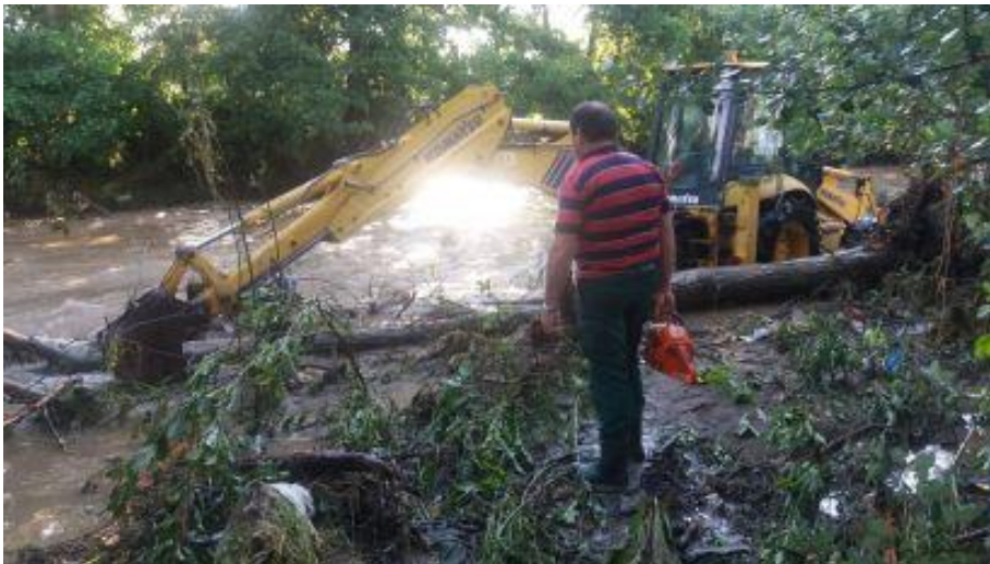
Interventie pentru decolmatarea Vaii Geoagiului
