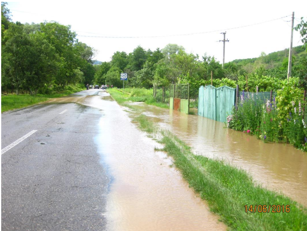
Inundatii pe strada Calea Romanilor din Geoagiu
